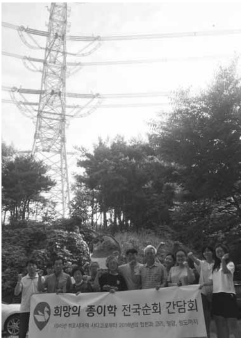
행정대집행 현장에 건설된 765kv송전탑
